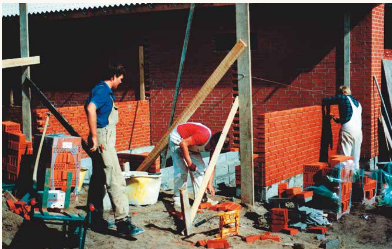
Tilbygning til eksisterende varmecentral. På billedet ses de to murersvende Mogens Larsen og Keld Thomsen samt arbejdsmand Lars Andersen
