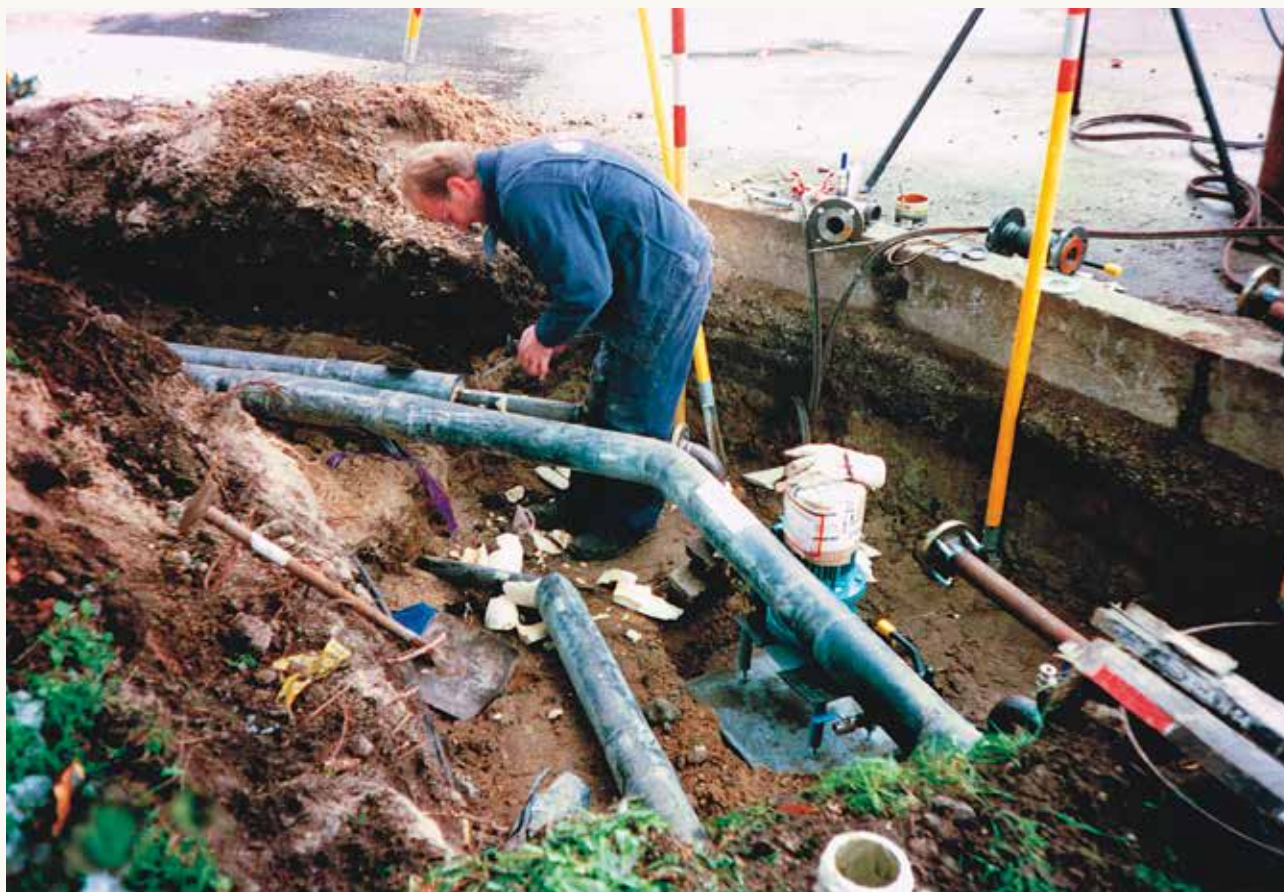
Varmemester Egon Carlsen på "fornyelsesarbejde" på eksisterende net
