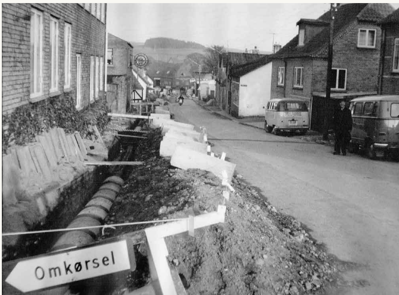
Billedet viser nedlægningen af hovedledningen i Kongensgade mod syd i 1963
