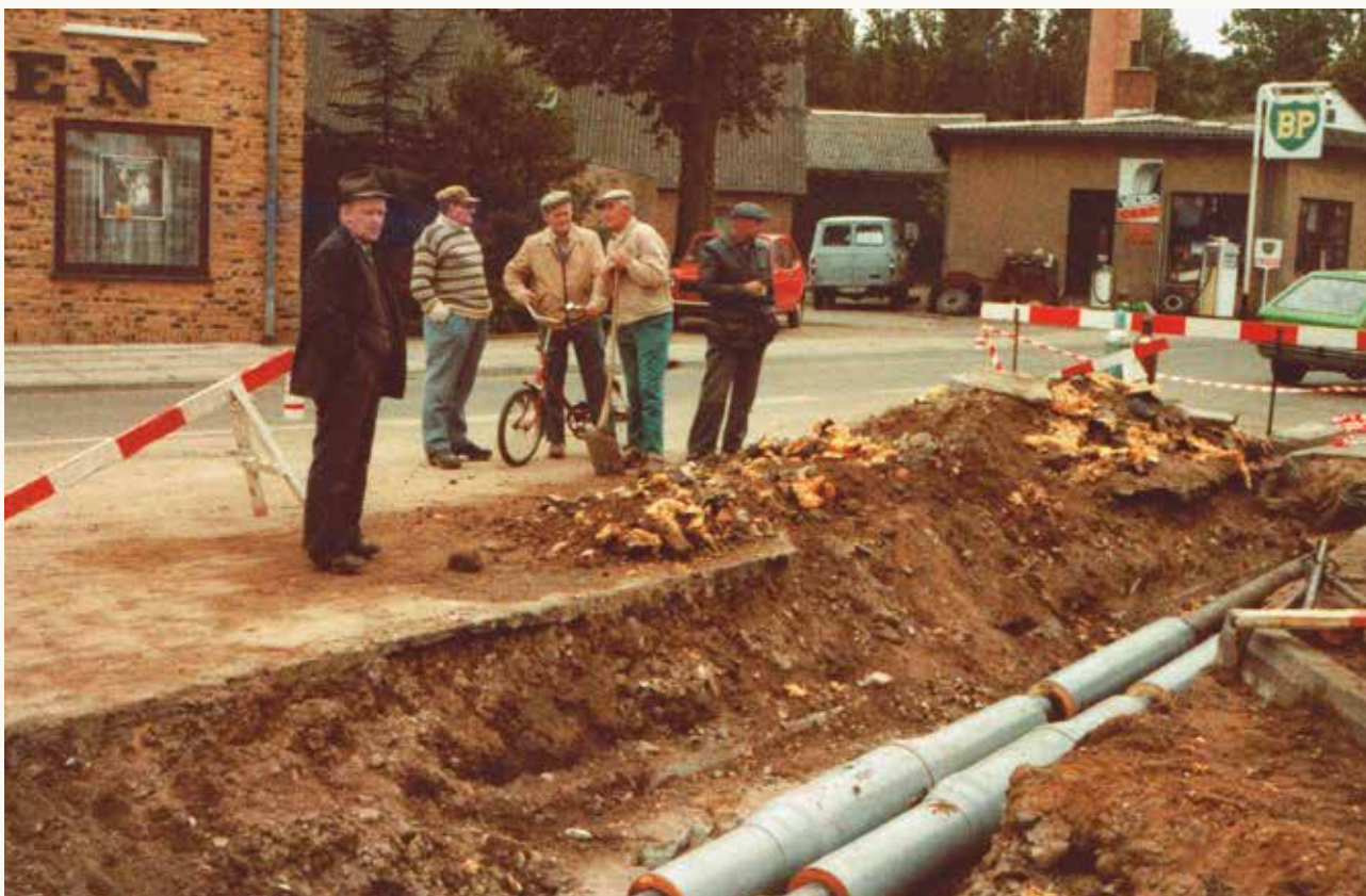
Større reparationsarbejde i krydset Kongensgade/Danmarksgade i sommeren 1978. På billedet ses fra venstre Marinus Jensen, Karl Winther Sørensen, formand for varmegærket Christian Jensen, Christian Hansen og Otto Sørensen
