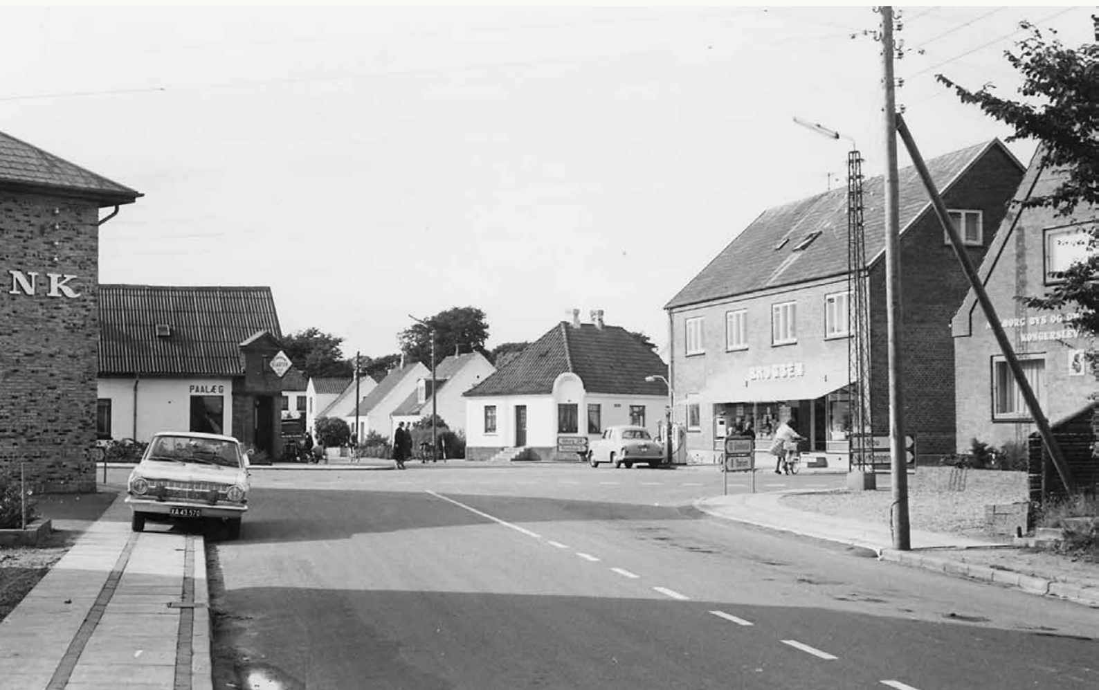
"Krydset mellem Danmarksgade og Kongensgade i begyndelsen af 60'ernes Kongerslev. Krydset mellem de to hovedgader i byen blev også omdrejningspunktet for hovedledninger i byens fjernvarmeforsyning".
