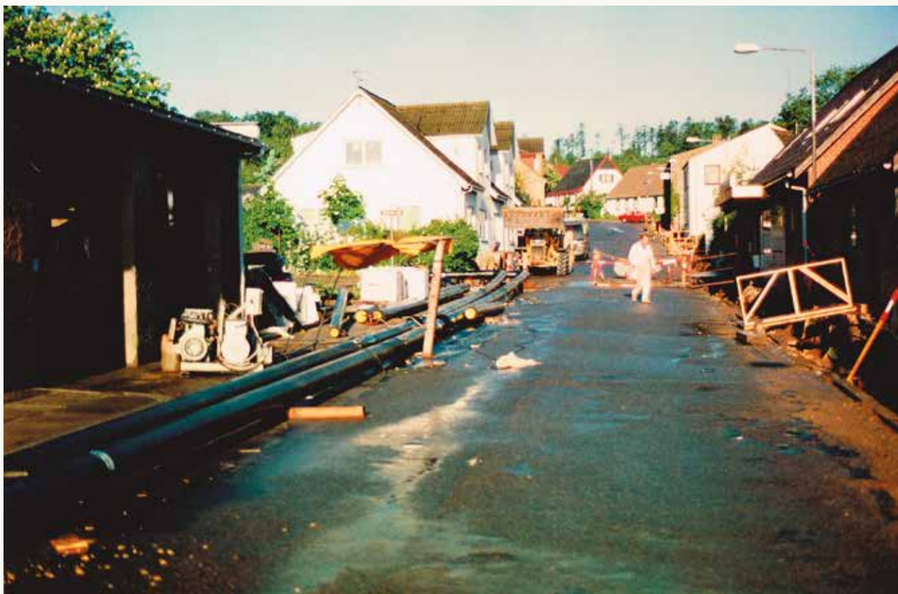
Ny hovedledning nedlægges i Kongensgade mod syd i forbindelse med overgangen til decentreal kraftvarme på naturgas
