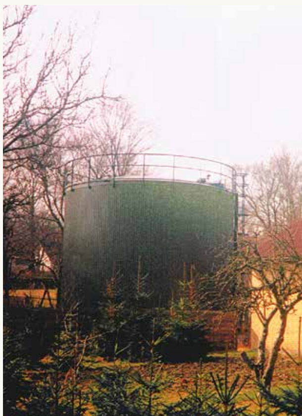
De 2 billeder viser forskellen på akkumuleringskøles tankens højde og størrelse efter udvidelsen fra de 450 m 3 til 600 m 3
